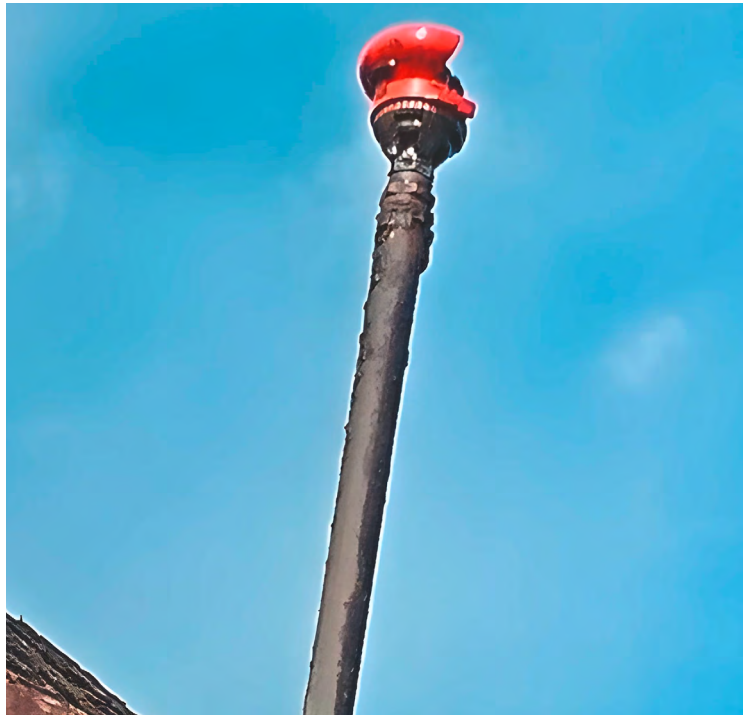
Exemple de fixation amovible d'un asperseur de dessus
